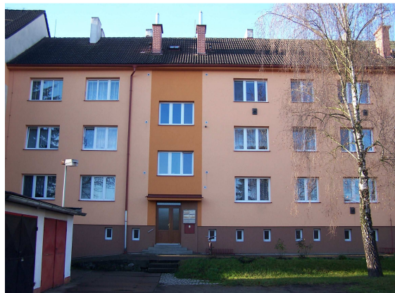
Dvorní východní fasáda
