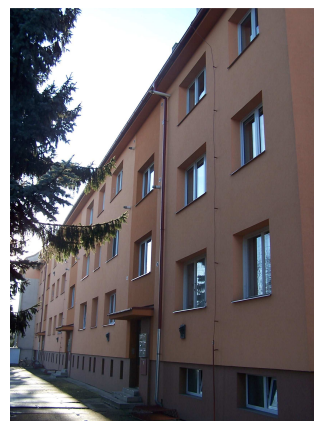
Dvorní východní fasáda
